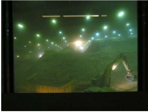
En dessous, ambiance lunaire. Les déchets sont excavés dans une nuit de brume toxique. Chaque cabine d'engin, étanchéifiée, est alimentée par des bouteilles d'air comprimé.
